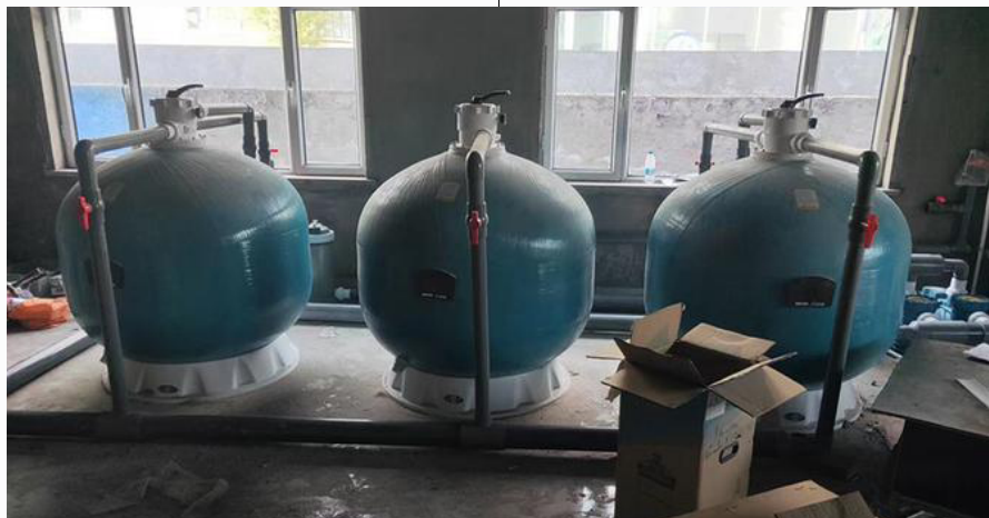
①【图 4】玻璃纤维材料制作的过滤砂缸（图片来源于润德体育设施）
